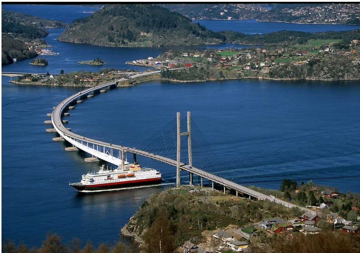
Nordhordalandsbrua, men med ei seilingshøgde på halvparten av det som er naudsynt i Langenuen.
